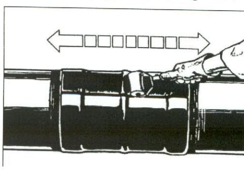
Рисунок 20 – Прикатывание замковой пластины после усадки манжеты
