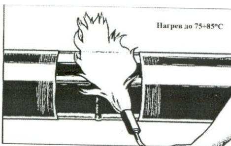
Рисунок 6 – Нагрев зоны сварного стыка
