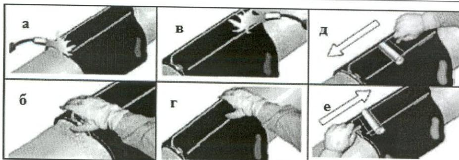
Рисунок 14 – Окончательная установка замковой пластины
